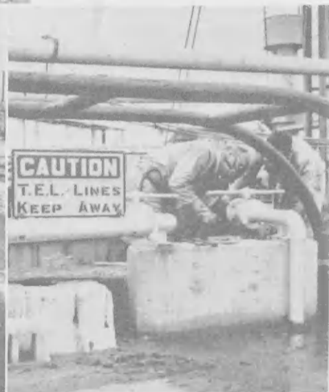
NA UN manifold special na No. 1 Finger Pier marineronan di Chemical Trader ta asega hose di manifold di e bapor na e linja di tetraethyl lead. E hose di neoprene di e bapor ta metal lined.
